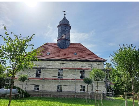
Außensanierung der Kirche Hartroda
