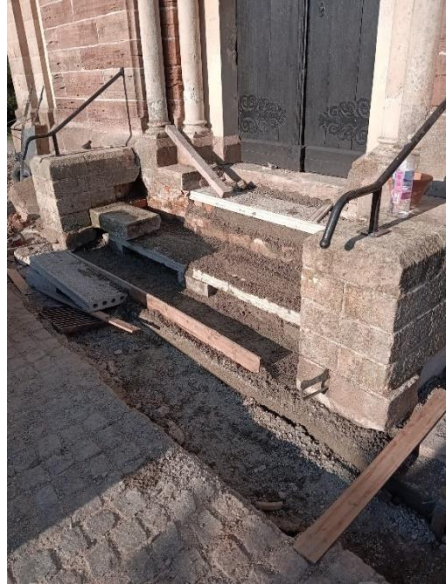
Alle Zugänge der Kirche in Altkirchen sind erneuert.
