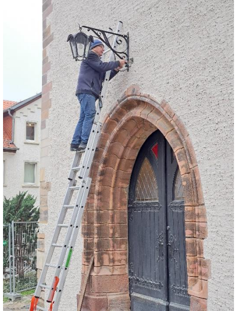
Außenlaterne wird wieder angebracht
